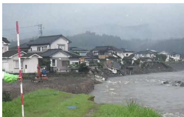
河岸侵食による家屋の倒壊(花月川)
