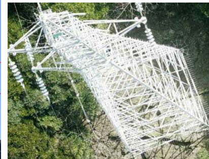
ドローンから撮影した鉄塔全体像
