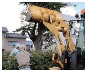
▲道路の通行に支障のある樹木を伐採の様子
