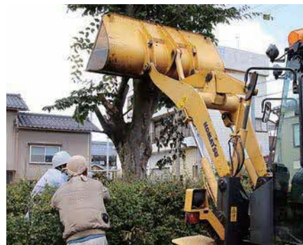
▲ 道路の通行に支障のある樹木を伐採する様子
