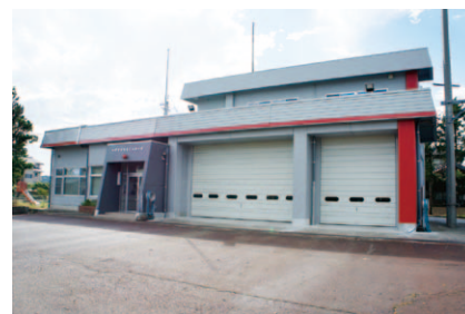
▲耐震改修した消防片山津分署
