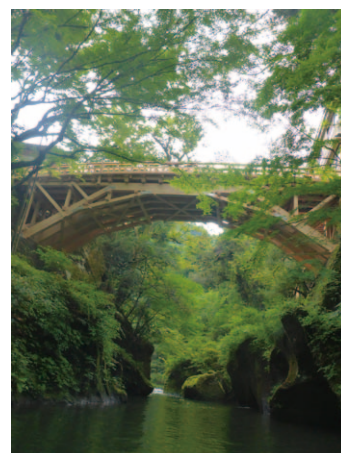
▲令和元年10月に完成した「こおろぎ橋」
