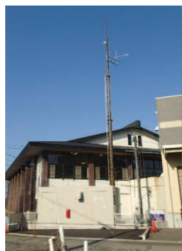
▲トランシーバー型無線機の中継局
