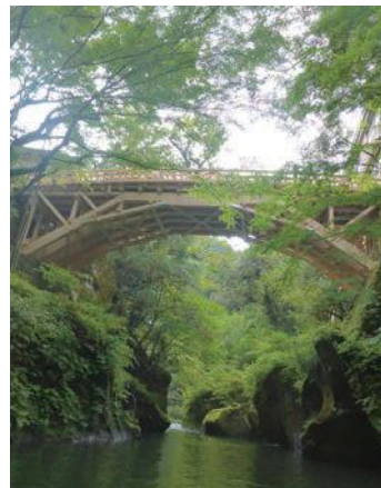
▲令和元年10月に完成したこおろぎ橋
