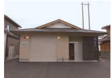
▲整備した動橋分団車庫
