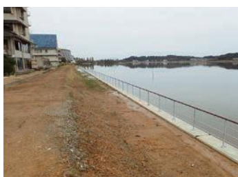
▲整備中の湖岸遊歩道
