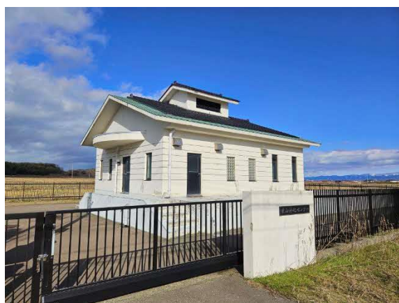
柴山浄化センター
