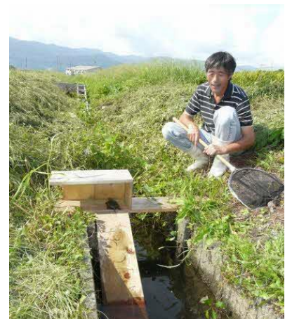
●亀かえるスロープの事例 （滋賀県高島市）
