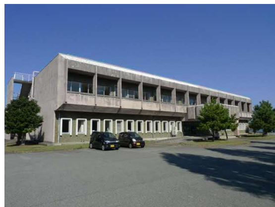
加賀市浄化センター(片山津処理区)
