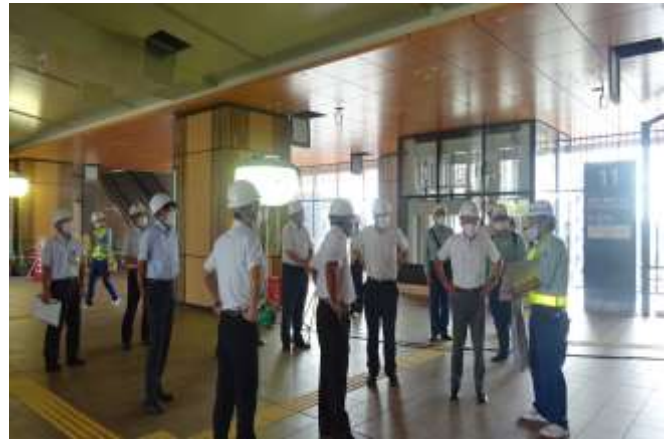
芦原温泉駅建設工事現場
