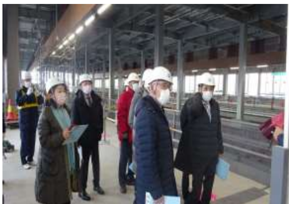
加賀温泉駅建設工事現場
