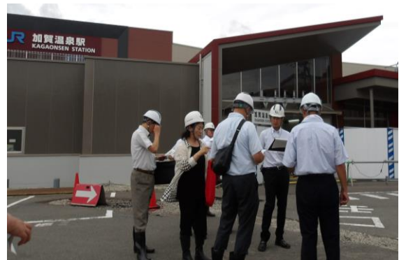
▲加賀温泉駅周辺工事現場（令和5年7月）
