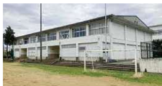
▲山代小学校体育館
