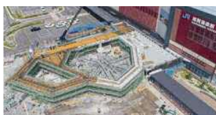
▲加賀温泉駅全天候型広場施設 （建設中）
