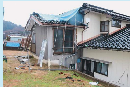
ブルーシートによる応急修理
