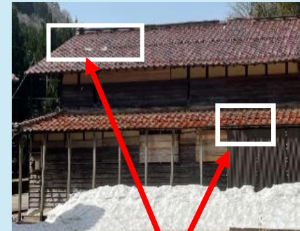
瓦破損（67枚）
