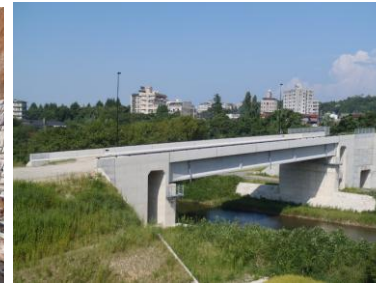
平成 26 年 11 月に完成した市道 B 第 14 号線（山代温泉 1 区～河南町）
