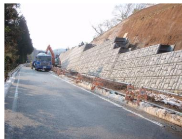
工事が進む加美谷線（山中温泉長谷田町地内）
