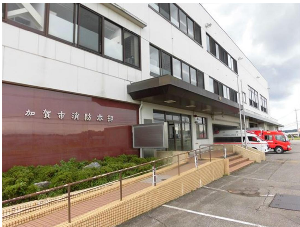
消防本部庁舎
