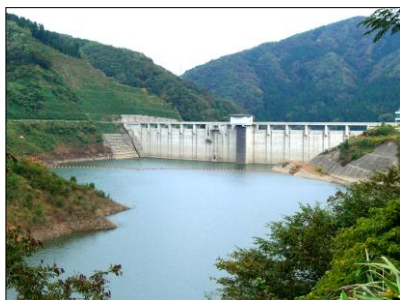
【九谷ダム上流側】
