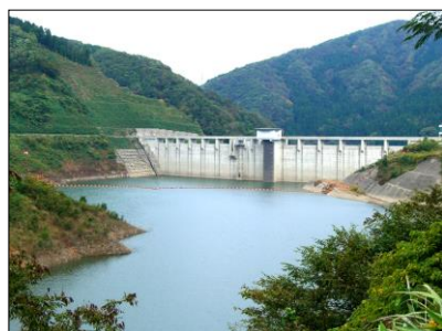
【九谷ダム上流側】
