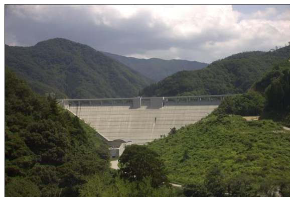
【九谷ダム下流側】
