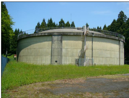
【片山津配水池（貯水量 5,000 m 3 ）】
