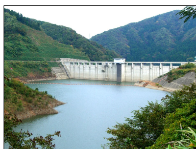
【九谷ダム上流側】
