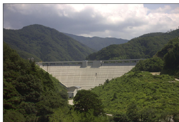
【九谷ダム下流側】
