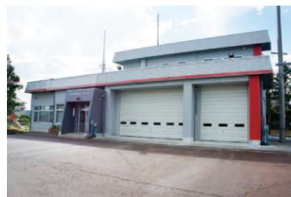
▲耐震改修した消防片山津分署
