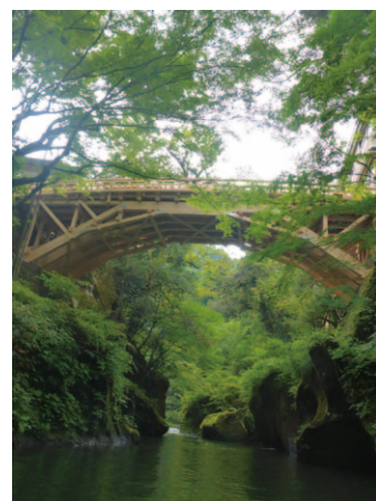
▲令和元年 10 月に完成した「こおろぎ橋」
