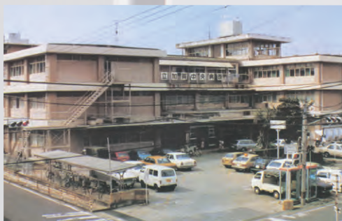
▲昭和40年に全館増改築工事が完成し、昭和48年、公立加賀中央病院と改称しました
