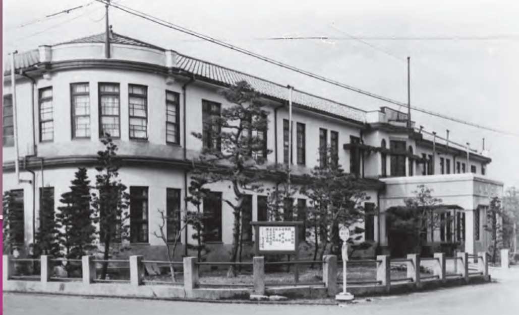
▲旧江沼病院建物。建物が竣工した当時は、大正12年の郡制廃止に伴い、郡立江沼病院から財団法人江沼病院と改称していました
