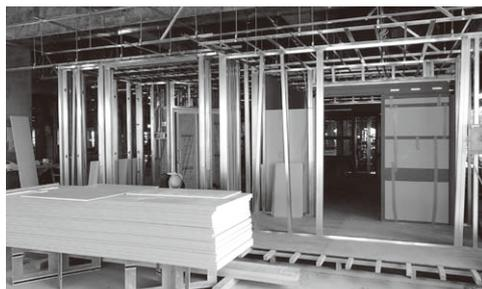
△現場見学会で見学する病室等の実寸模型を製作している様子
