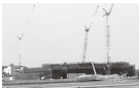
▲工事の様子（国道8号側から撮影）5階の工事まで進むと遠くからも見えるようになってきました。
