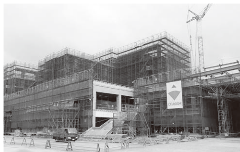
▲昨年8月から進めてきました病院本体の工事は最上階の工事に掛かりました。
