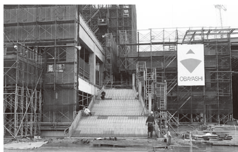
▲病院の2階へ直接出入りが出来るよう外階段を整備します。この階段は避難階段としても利用するため、大きな階段としています。
