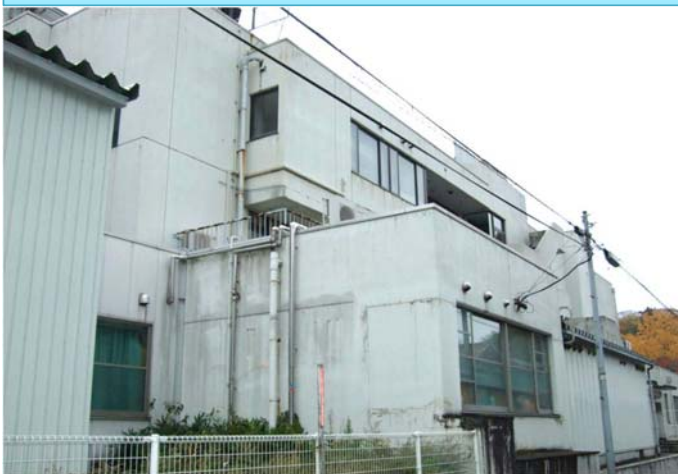
加賀市民病院 診療棟 昭和57年建設
