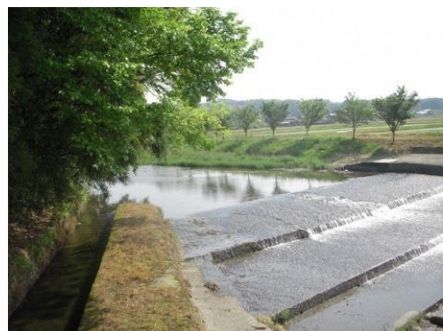
矢田野用水取水堰（横北町）
