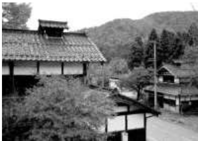
荒谷町 煙出しをもつ民家
