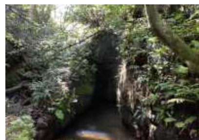
掘り抜き工事で作られた水路
