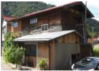
木地挽き作業場（昭和16年（1941年）建築）
