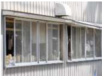
通りからみた木地挽き作業場の様子
