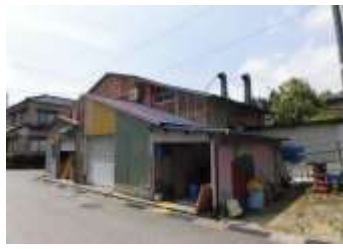
塗装作業場（昭和35年（1960年）建築）
