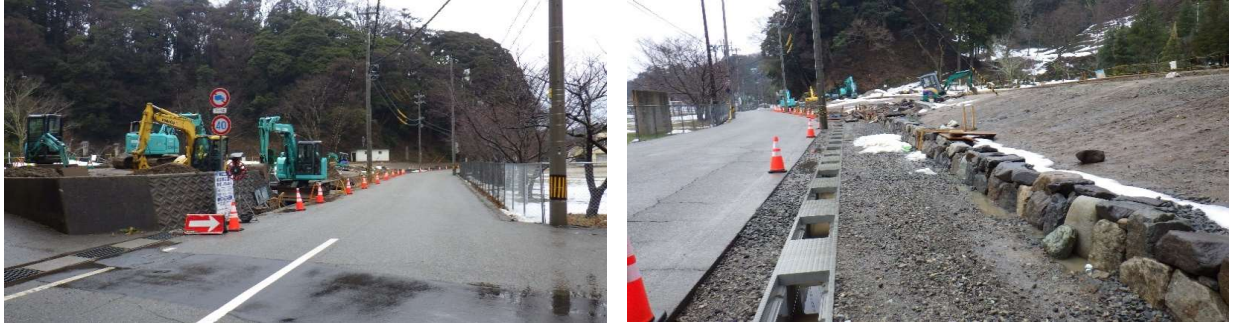
現況写真 錦城山入口部
