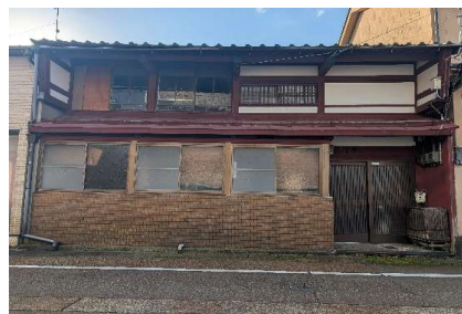
②現況(改修前)写真 (カフェ予定)
