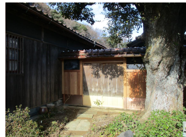
中越家脇門保存修繕完了 R8.1月
