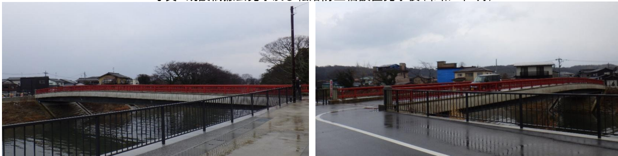
写真 既設橋撤去完了及び転落防止柵設置完了後(令和7年2月)
