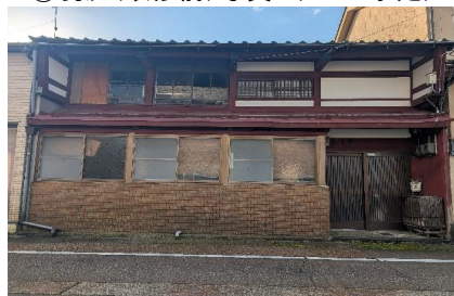
②現況(改修前)写真(カフェ予定)
