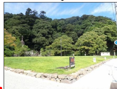
錦城山公園修景整備事業 R7
