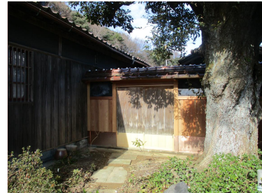
中越家脇門保存修繕完了 R8.1月
