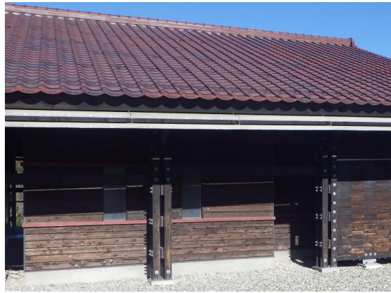
外壁の例（橋立自然公園管理棟）
