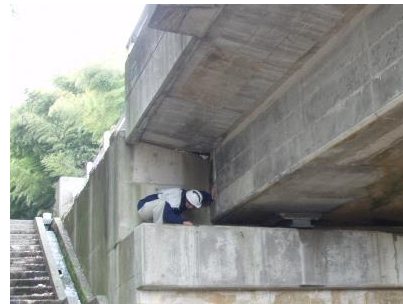
日常的維持管理（橋下面）
