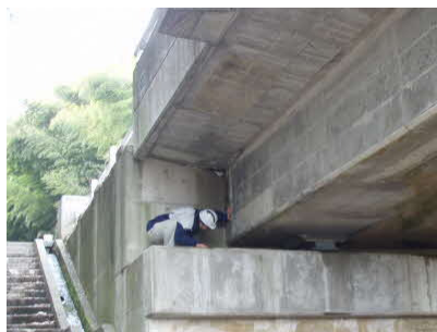
日常的維持管理（橋下面）
