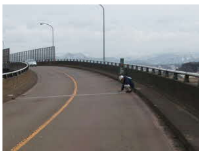
日常的維持管理（橋上面）
