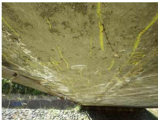
「30 熊坂新橋」【健全性Ⅱ(ひびわれ)】 ※ASR によるものと推測
