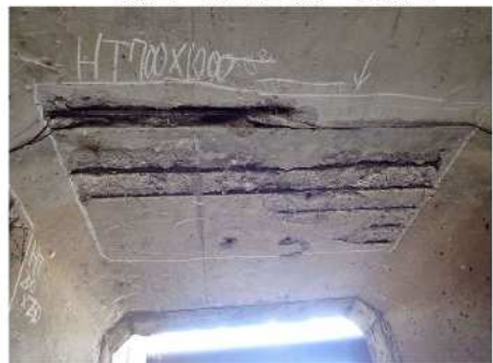
頂版：鉄筋露出(1000mm×700mm)
