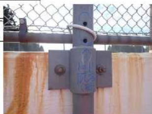
高欄：ボルトの欠損
