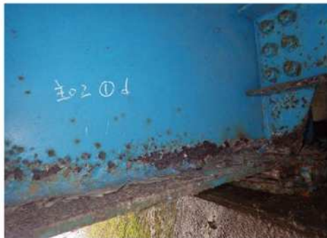
橋桁の塗装のはがれ、劣化
