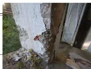
下部：補強材の損傷 (400mm×200mm)
