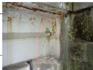
主桁：補強材の損傷
