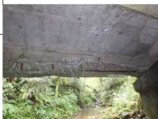
主桁：鉄筋露出 (2800mm×250mm)
