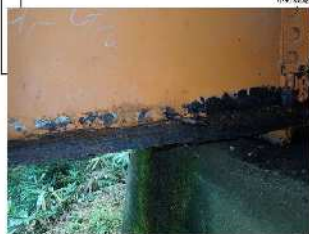
主桁: 局所的な腐食 (1000mm)
