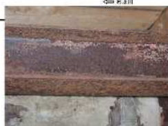
横桁：表面的な腐食
