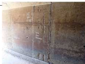
側壁：鉄筋露出 (400mm×1000mm)
