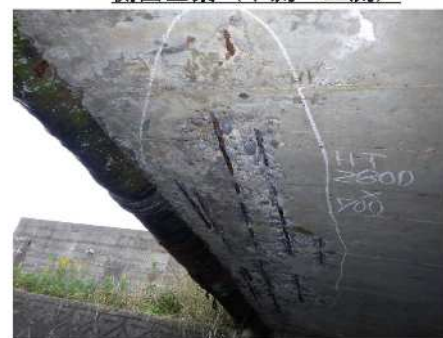
主桁：鉄筋露出(2800mm×700mm)
