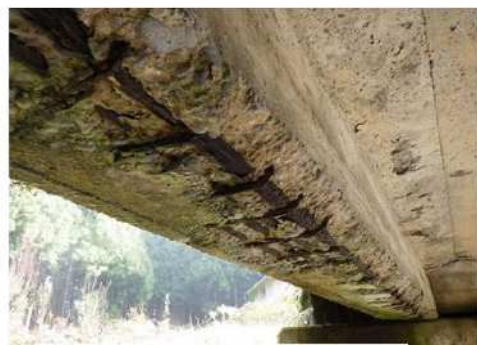
コンクリート主桁の鉄筋露出
