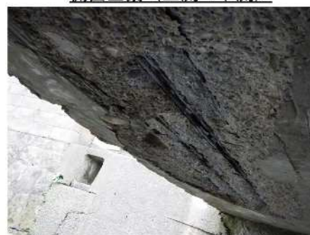
主桁: 鉄筋露出 (2600mm×1000mm)
