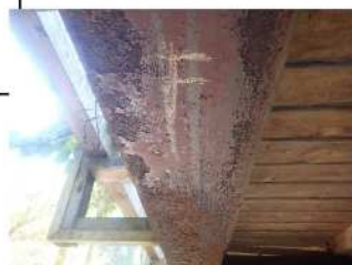
主桁：表面的な腐食
