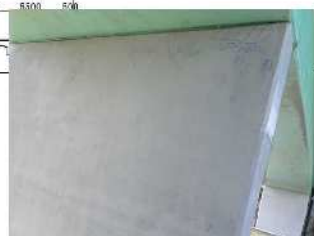
下部：ひびわれ1.0mm うき (500mm×200mm)
