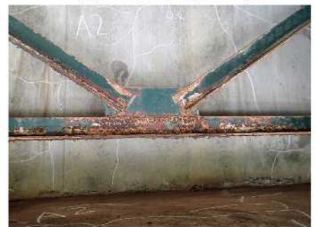
横桁：断面減少を伴う腐食
