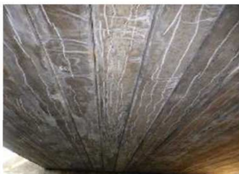
橋桁下面のひびわれ、漏水、遊離石灰析出
