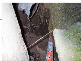
下部 (擁壁): 土砂流出
