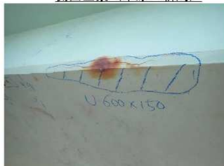
主桁：ひびわれ・錆汁，うき (600mm×150mm)
