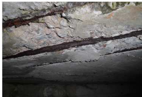
主桁：鉄筋露出
