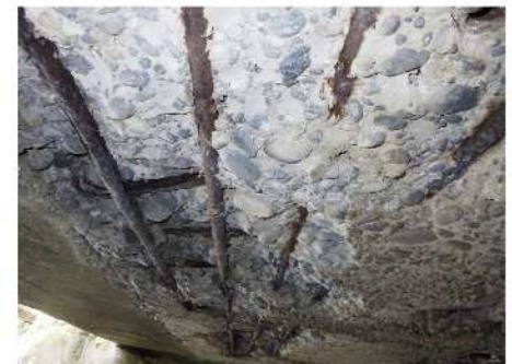
主桁：鉄筋露出 (4500mm × 800mm)
