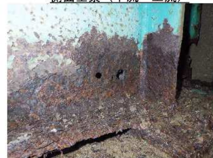
主桁：桁端部の広範囲に渡る腐食
