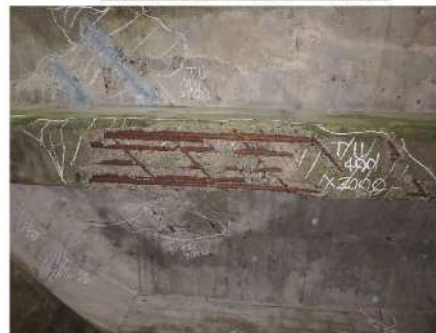
主桁：鉄筋露出 (400mm×2000mm)
