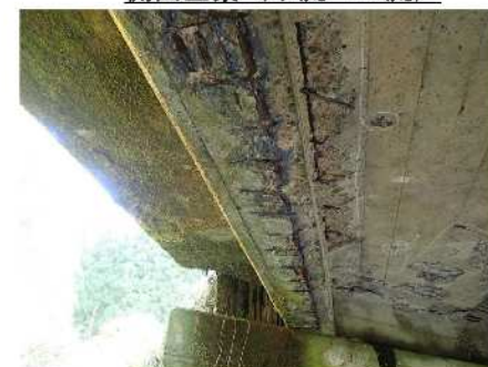
主桁：鉄筋露出(5000mm×300mm)
