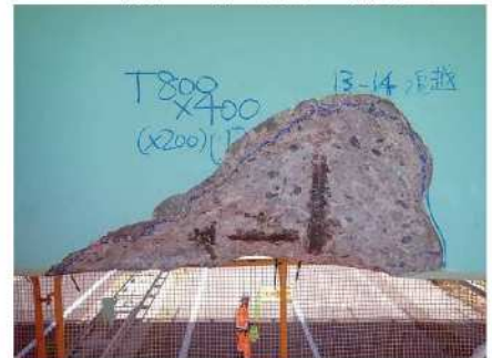
主桁：鉄筋露出 (800mm × 400mm)
