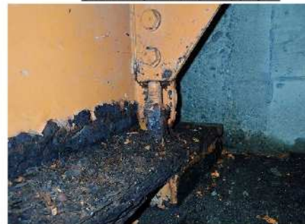
支承: 機能障害 (アンカーボルト腐食)
