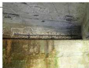
主桁：鉄筋露出 (1800mm×200mm)
