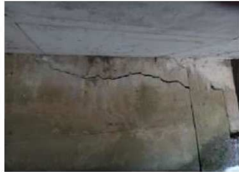
下部工のひび割れ
