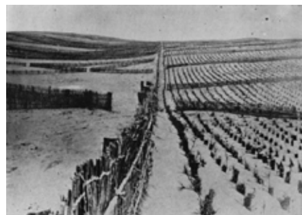
写真 2-1 植栽及び砂防垣の状況（大正7年） 資料：『砂濱国有林海岸砂防事業の概要』
