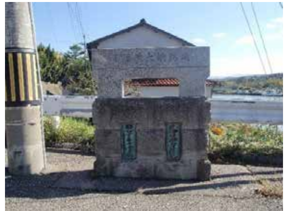
写真 3-17 旧塩屋大橋跡地
