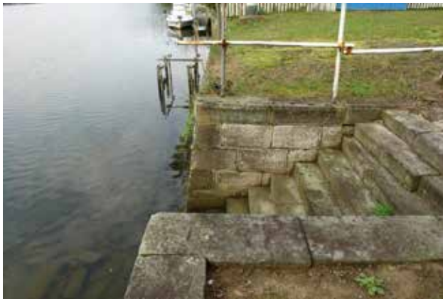
写真 3-16 瀬越地区の船着き場跡
